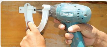
Con el hilo extendido marcar las perforaciones y fijar los ganchos con los tornillos a una distancia **no mayor de 60cm** uno del otro. Recordar que las bajadas, uniones canaleta y/o ganchos de fijación, no deberán estar a una distancia menor a 5cm del extremo de la techumbre.
