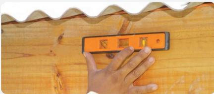
Presentar sobre el lugar un trozo de perfil de canaleta con el gancho incorporado, o en un esquinero, a fin de fijar el extremo de inicio de la instalación, es decir, el primer gancho desde el punto más alto hacia el más bajo. Si el tapacán no es perpendicular al piso, éste deberá complementarse con un listón de sección triangular, a fin de lograr dicha perpendicularidad, es decir, a plomo.
