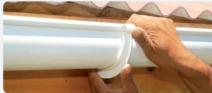
Continuar agregando y pegando los tramos necesarios, siempre unidos por una unión canaleta. Si hiciera falta cortar algún tramo de la canaleta, éste se realizará marcando con lápiz y con la ayuda de un gancho o unión como guía. Cortar por la marca con sierra, eliminar las rebabas con una lija fina.
