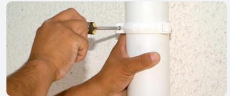
Armar el tramo desde la bajada hasta el tubo de bajada, combinando codos, coplas y trozos de tubo de ser necesario. Tener en cuenta que el primer codo después de la bajada no debe pegarse a la bajada, como tampoco el otro codo sobre la parte del tubo de bajada. Cuando se utilicen coplas para unir un codo o tramos de tubo de bajada, sólo se pegará uno de sus extremos, quedando sin pegar el extremo superior.
