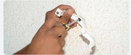
**Bajadas:** ubicar puntos de fijación de las abrazaderas del tubo de bajada con una plomada. Perforar la pared, insertar tarugo de fijación, luego atornillar. La distancia entre abrazaderas será como máximo de 2m.
