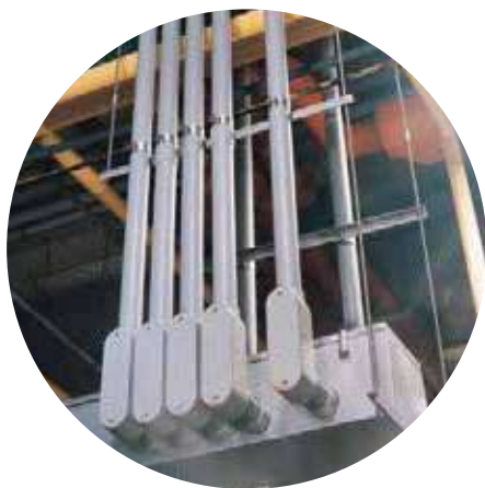
Sistema conduit PVC SCH 40
