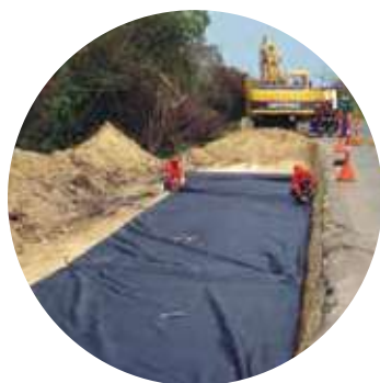
Geotextiles tejidos y no tejidos en polipropileno
