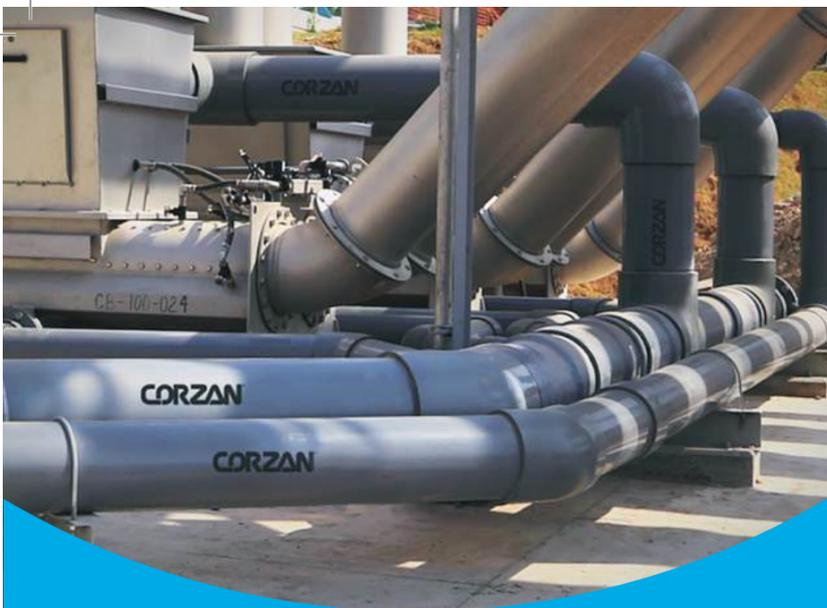
La tubería marca CORZAN® de **Durman**®, está hecha con resina de Poli(cloruro de Vinilo) Clorado (CPVC).
